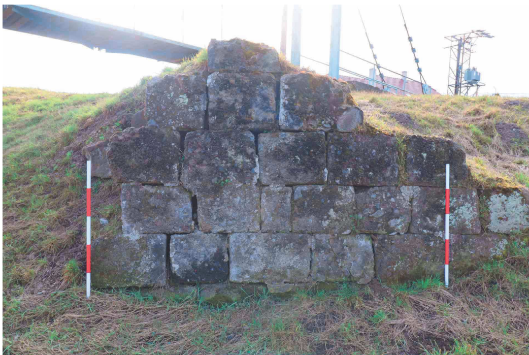
Obr. 21. Lenartovce. Podstatne subtílnejšie zachované murívo nábehu mosta na pravom brehu rieky. (Foto: autor).
