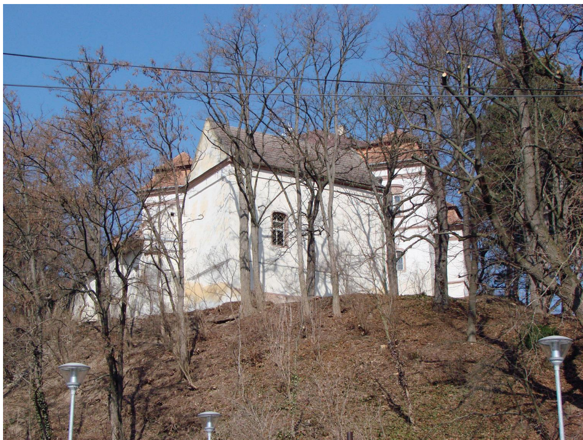
Obrázok č. 5: Pohľad z juhu na kaplnku a kaštieľ (Foto: M. Havlík)
