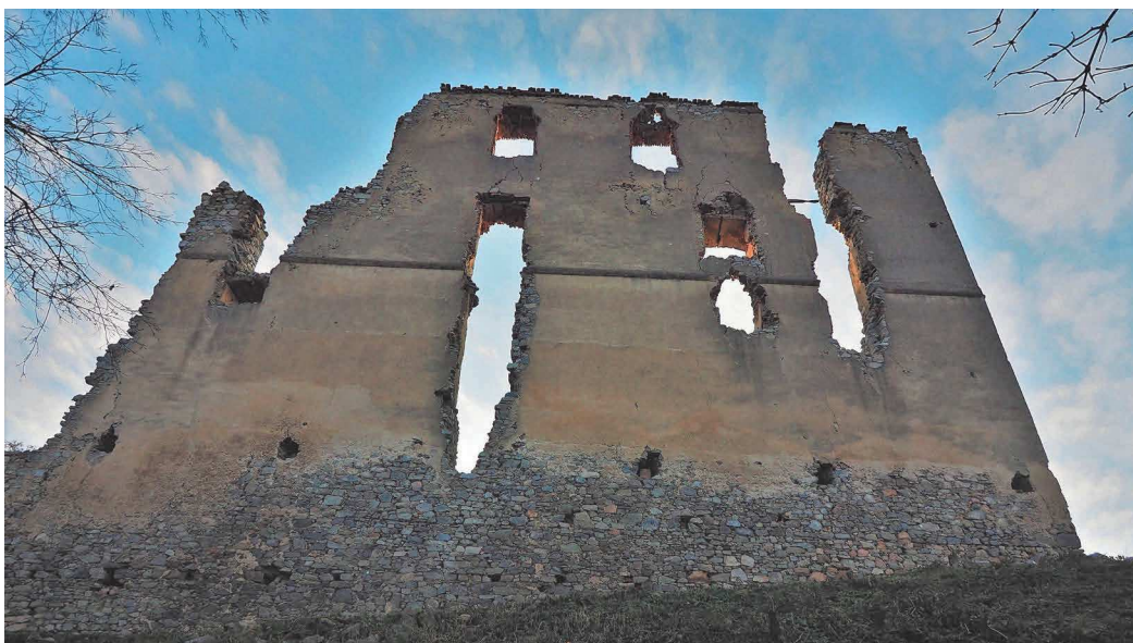
Obr. 9. Čelná fasáda severovýchodného paláca v predhradí. (Foto: M. Bóna, 2020).
