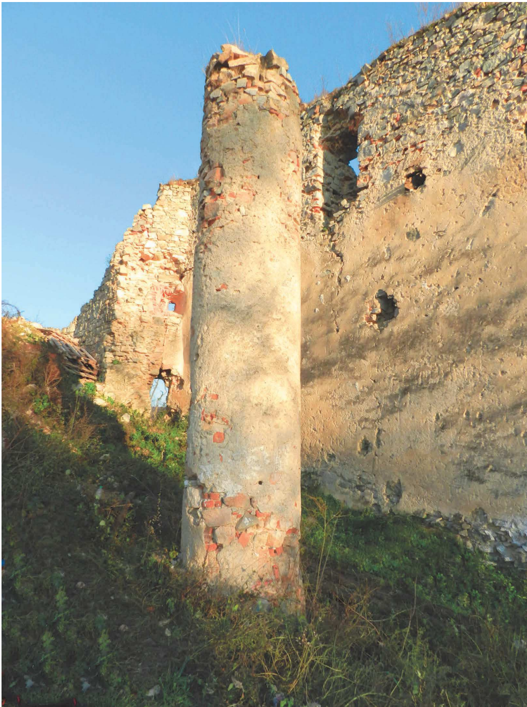
Obr. 7. Zvyšok hospodárskej budovy v predhradí s nosným stropným pilierom. (Foto: M. Bóna, 2016).
