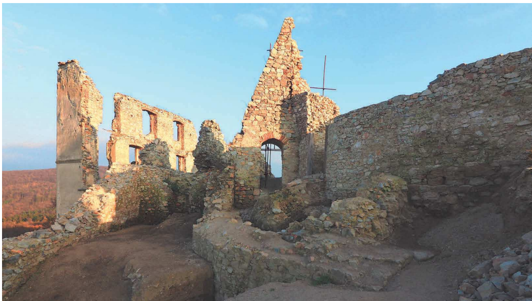
Obr. 3. Západný pohľad na zvyšky parkanového múru v popredí, na priečodný oporný pilier a vľavo severovýchodný palác v predhradí. (Foto: M. Bóna, 2020).
