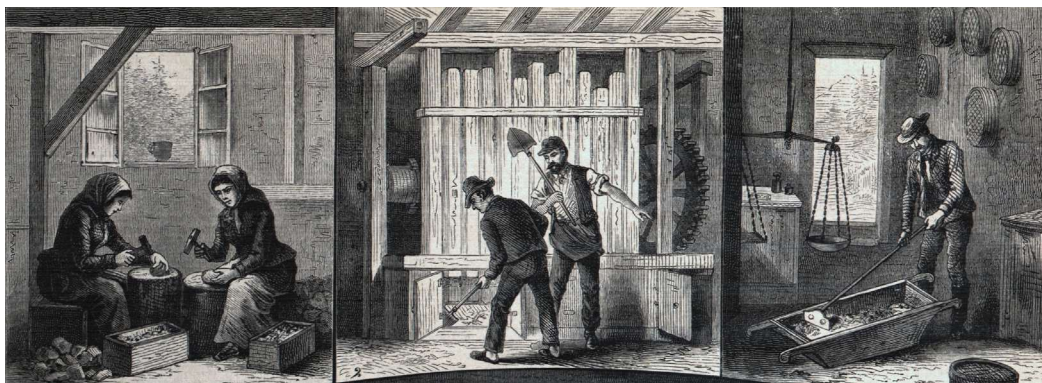
Obr. 4. Dobová ilustrácia z roku 1885, ktorá zobrazuje triedenie kremeňa, jeho drvenie v stupe, preosievanie a miešanie surovín na výrobu sklárskeho kmeňa.
