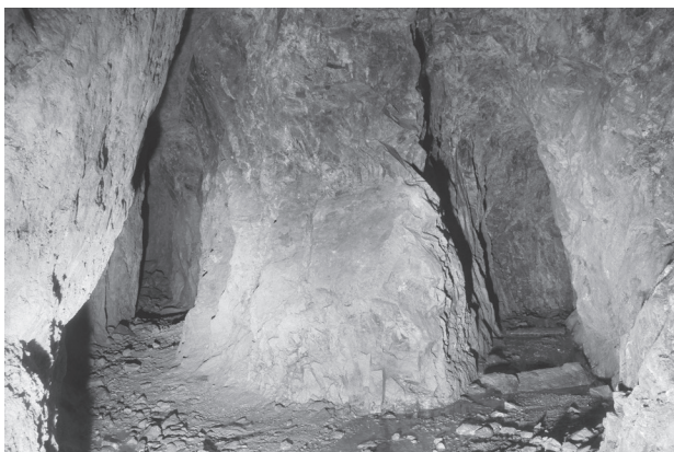
Obr. 5. Rozdvojenie (vidlica) kresanice. Baňa v doline Jasenianskeho potoka (foto M. Žec).
