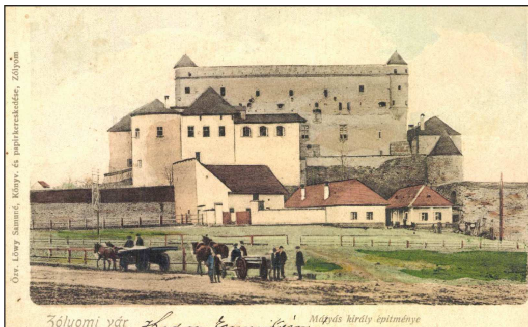
Obr. 13. Pohľad na zvolenský zámok od západu – z bodu pri niekdajšom rybníku. Vľavo ešte vidno stojaci úsek západného hradbového múru. Jeho napojenie na delostrelecký bastión (vpravo) zakrývajú objekty, ktoré tu postupne vyrástli: dom pôvodne pre nemeckého obuvníka (1753), zázajdný hostinec (tesne pri bastióne) a ďalší dom. Historická pohľadnica z roku 1903. 149
