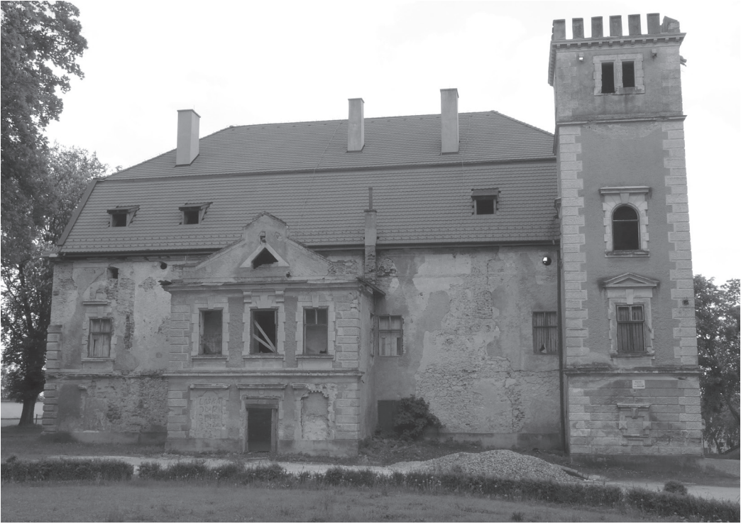
Obr. 10. Pohľad na kaštieľ od severu. Po stranách rizalitu vidno zamurované vstupy do prevetov z 2. stavebnej etapy. Autor: Miroslav Matejka.
