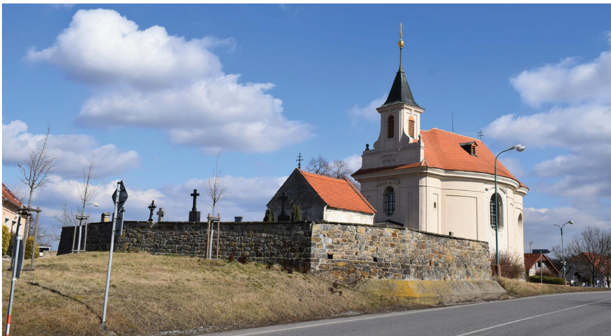
Obr. 18. Velenka, okres Nymburk, kostelní hřbitov u kostela sv. Petra v okovech (1734) ukrývá i pozoruhodnou márnici z počátku 19. století. (Foto: autor, 2018).
